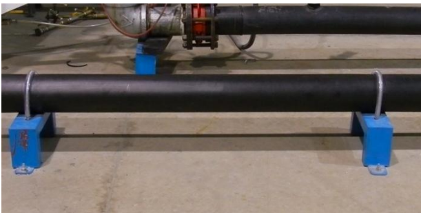
Foto 8: Recuperación final de la sección original, tubería con RD 41, Prueba 4.
