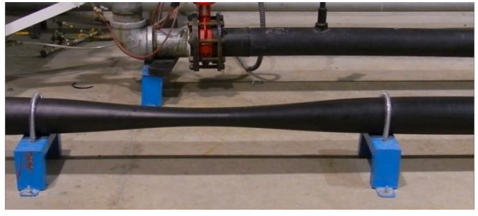
Foto 5: Deformación de la tubería RD 41 durante la segunda depresión, Prueba 4.
